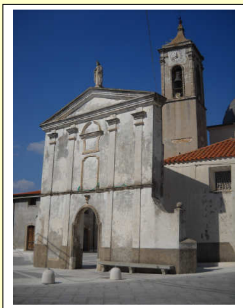
FOTO 11) Vista dell'originale facciata-diaframma
